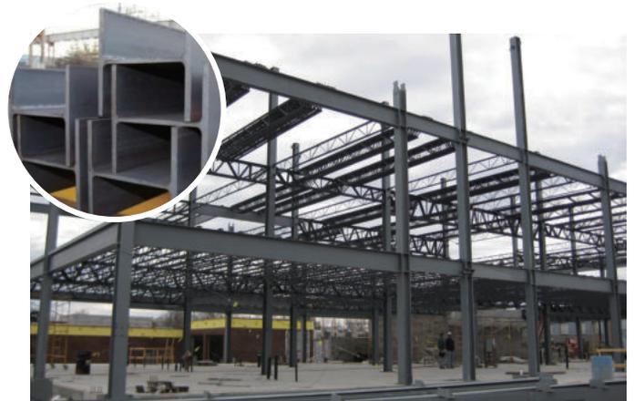
〈그림 3〉H형강 제품 사진 및 H형강 적용 철골구조물
