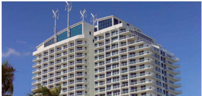
〈그림 5〉 플로리다 주 힐튼 포트 로더데일 비치 리조트에 설치된 소형 풍력발전기
