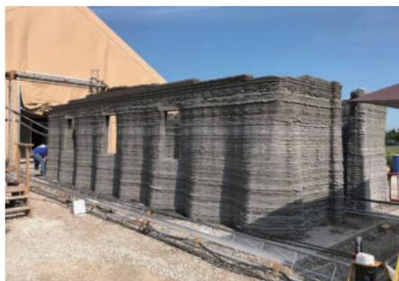
〈그림 2〉 미 해군 3D 프린팅 콘크리트 막사
