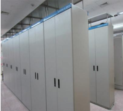
**기술내용** 통합제어시스템은 발전소에서 사람의 두뇌와 신경망에 해당하는 발전소 핵심 설비로서 시시각각 변화하는 전력 수요에 따라 발전량을 신속히 제어하고, 각종 기기의 운전 상태를 종합 감시하여 안정적 전력 생산에 중심 역할을 하는 시스템. 본 개발 기술의 가장 큰 특징은 기존에 제작사가 상이하여 개별 운영되던 보일러, 터빈, 발전기의 제어시스템을 첨단 IT 기술을 활용하여 동일한 하드웨어와 소프트웨어 기반으로 통합 개발함. 금번 개발의 주요 내용은 동일 하드웨어 기반의 통합 제어기, 국제 규격(IEC 61131)을 준용한 제어 프로그램 개발 및 발전소 운전상태를 모의하는 시뮬레이터를 개발하고 이를 활용하여 제어시스템 전 범위 사전 성능검증 및 실증시험을 실시함. 또한 실제 운영 중인 발전소의 기존 제어시스템을 개발한 제어시스템으로 교체하고, 실 계통의 상업 운전을 통해 사업화 기술을 확보함
