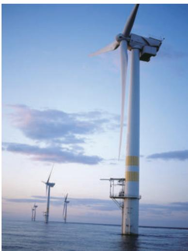
적용하기 위해 3MW급 해상풍력 발전용 모노파일 인증 프로세스 개발 및 인증을 진행한다. 60톤 이상의 후육강관 용접이므로 용접량을 줄이기 위해 네로 갭 용접기를 개발하여 모노파일 시제품 생산에 적용하고 있다. 더불어 음극화 보호를 이용한 전기방식 부식방지 상세설계 및 부식속도 측정장치 개발도 계획 중이다.
