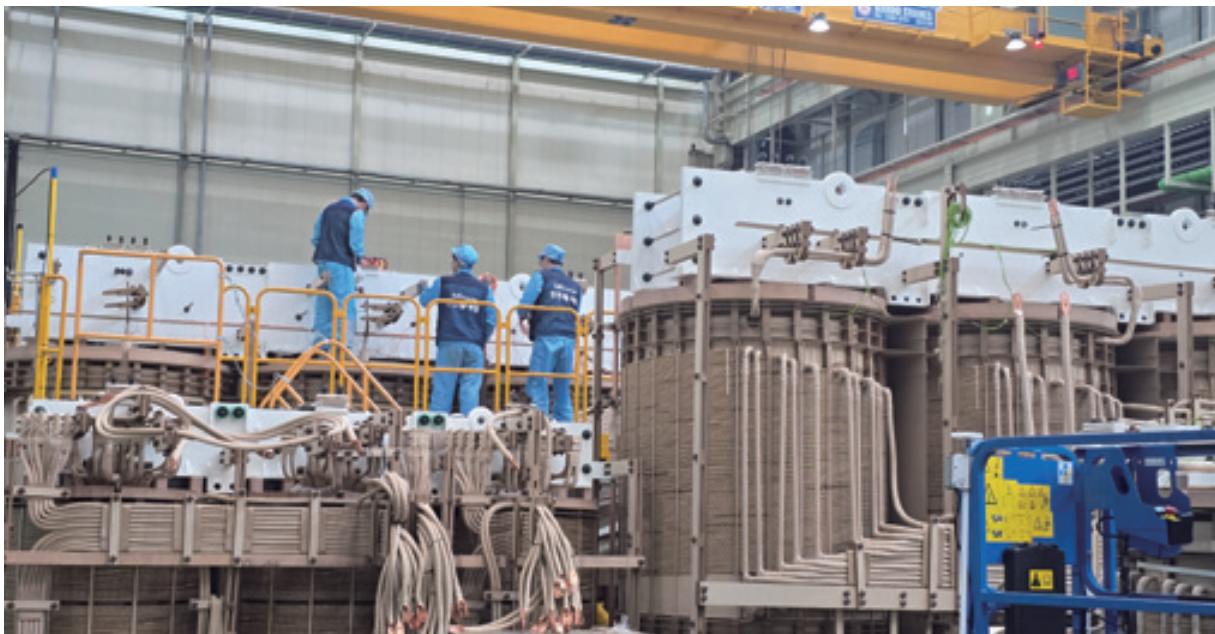
대형 전력변압기 내부에 들어가는 핵심 부품인 철심과 구리 코일(권선)을 조립하는 모습. 이 거대한 부품들이 외함에 들어간 뒤 절연유로 가득 채워져 고전압을 차단하고 열을 식힌다.
